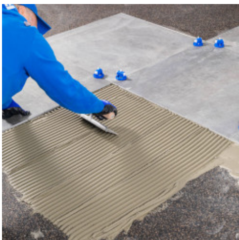
Sur un support convenablement préparé, appliquer la colle pour coller les feuilles d'isolation phonique
