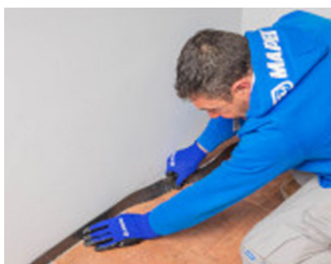
Appliquer le ruban adhésif Mapesonic Strip sur le périmètre de la pièce
