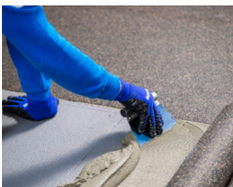
Sur un support convenablement préparé, appliquer la colle pour coller les feuilles d'isolation phonique
