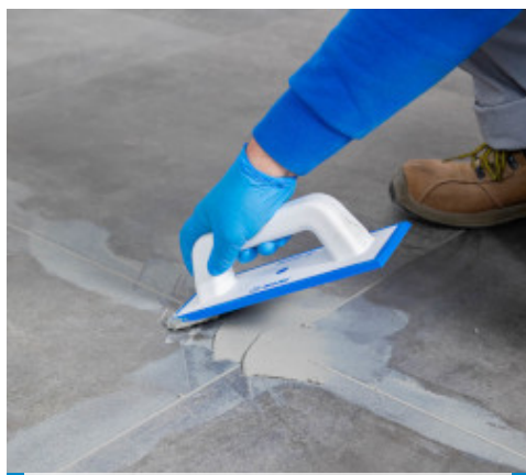
Jointoiment de la surface de la pièce
