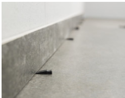
Poser la plinthe sur le pourtour de sorte qu'elle ne soit pas en contact direct avec le revêtement de sol
