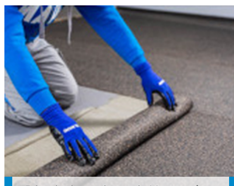
Dérouler les rouleaux de Mapesonic CR le long des surfaces concernées, en veillant à parfaitement juxtaposer les lés l'un à côté de l'autre
