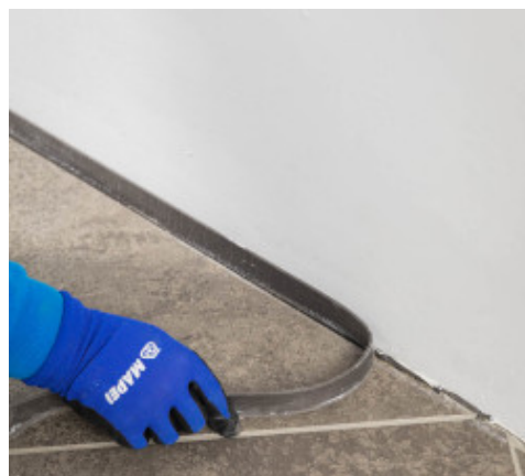
Une fois le mortier de jointoiment durci, découper le bord du périmètre en coupant l'excédent de Mapesonic Strip
